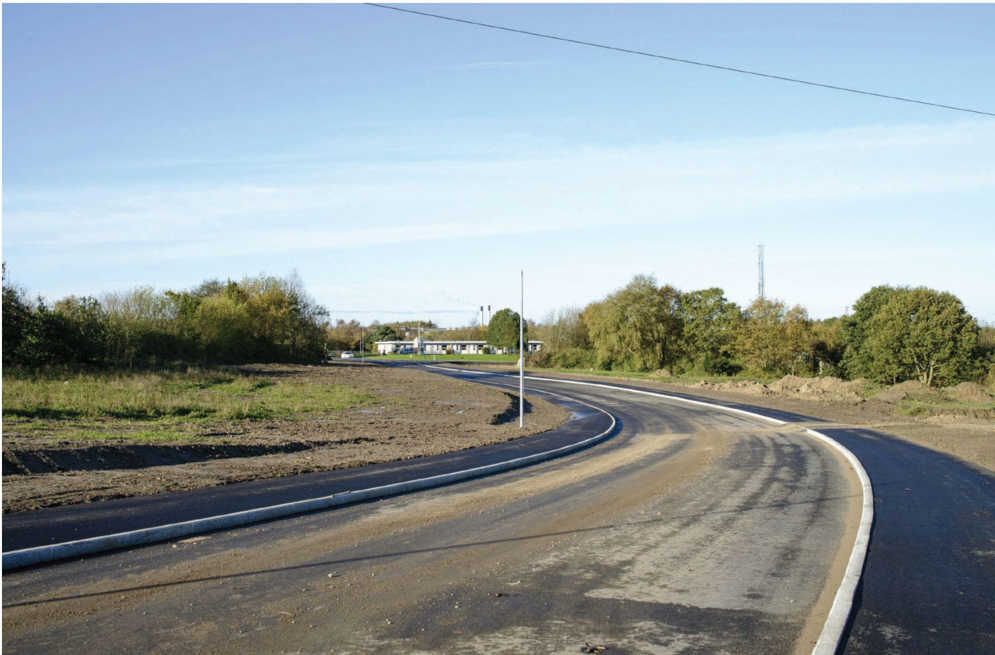
Position 3 – Eksisterende forhold
