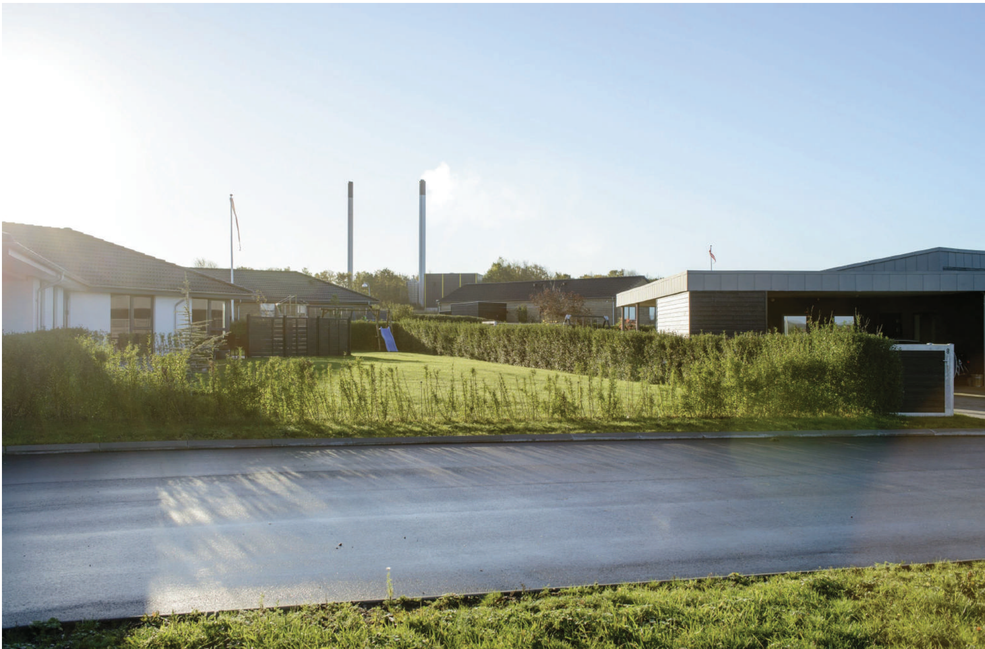
Position 1 – Eksisterende forhold
